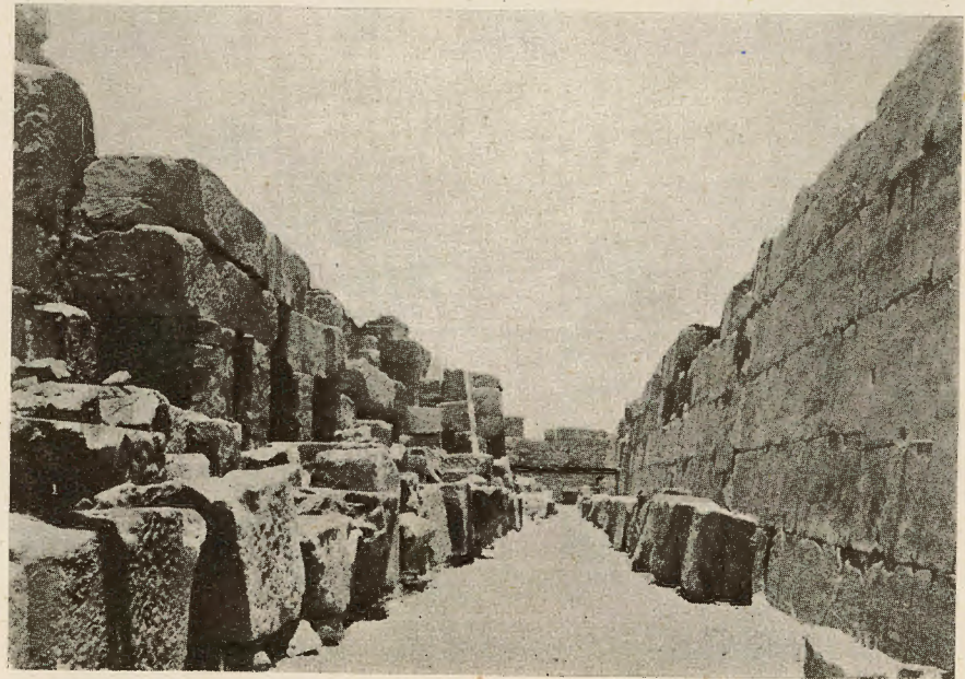
Le corridor de l'Est, avant et après le dégagement. Photos prises au sol, adossé au mur sud.
